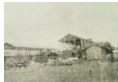
「新築中の第3、第4校舎」 昭和25年1月落成(木造2階建て)
